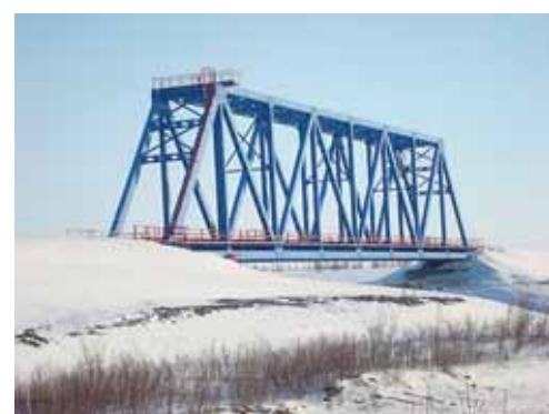
Один из 37 мостовых переходов железной дороги «Обская — Бованенково»
