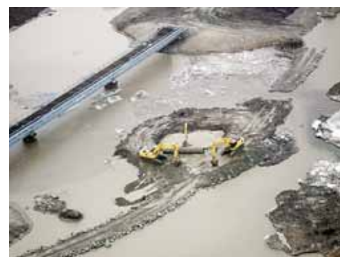
Строительство мостового перехода через реку Юрибей
