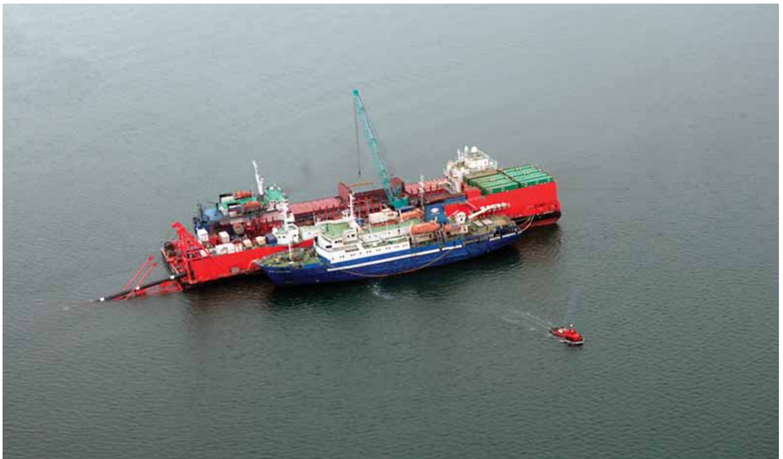
Работа трубоукладочного судна MSTS Defender в Байдарацкой губе
