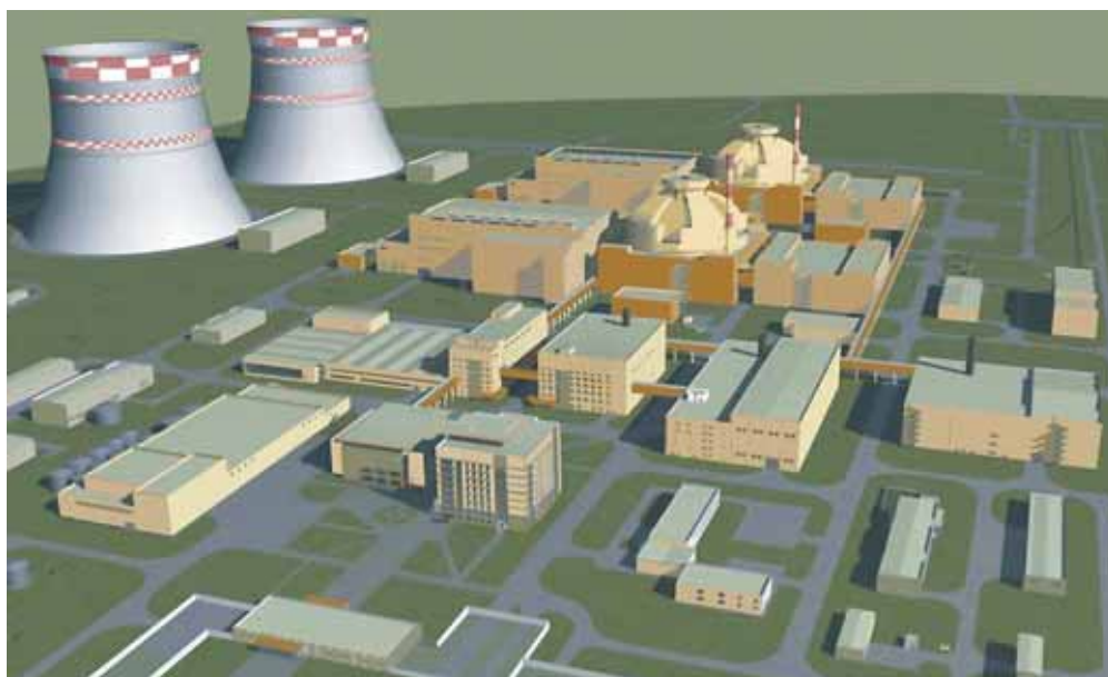
Общий вид двухблочной АЭС проекта АЭС-2006
