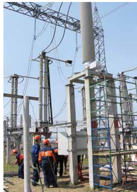
Монтаж трансформаторов тока на ОРУ-500 кВ НВАЭС
