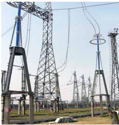
Монтаж ОПН-500 на НВАЭС
