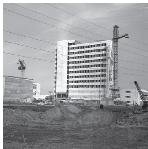
Строящийся высотник НИИИС
